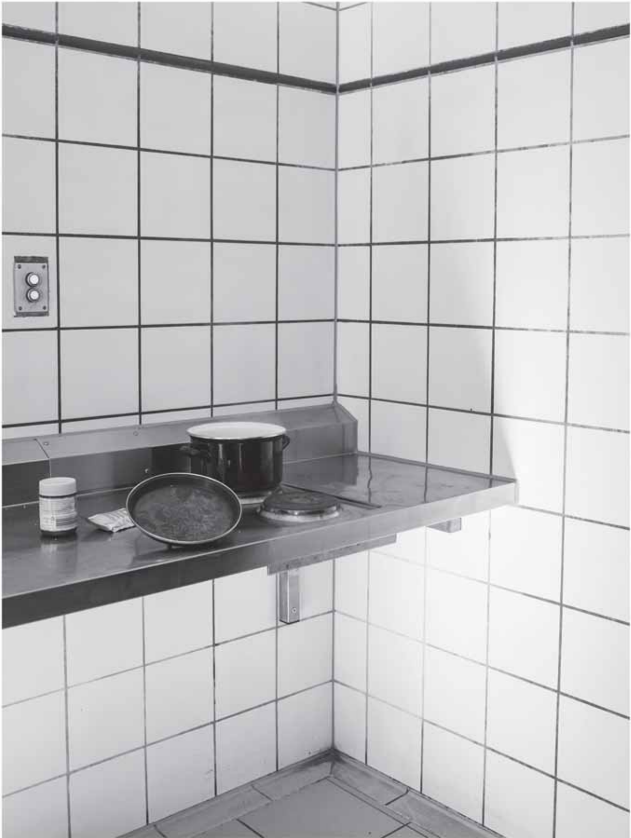
Die Küchen des Anker-Zentrums Zirndorf sind sehr rudimentär ausgestattet. Die Herdplatten gehen aus Unfallschutzgründen nach zehn Minuten Betrieb automatisch aus und müssen erneut angeschaltet werden
