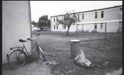
Die Max-Immelmann-Kaserne in Manching liegt total abgelegen. Der nächste Supermarkt ist 40 Minuten zu Fuß entfernt.
